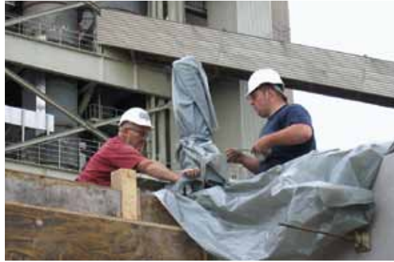
Abb. 12 Schutz der Anschluss- bewehrung mit Kunststoffolie.
