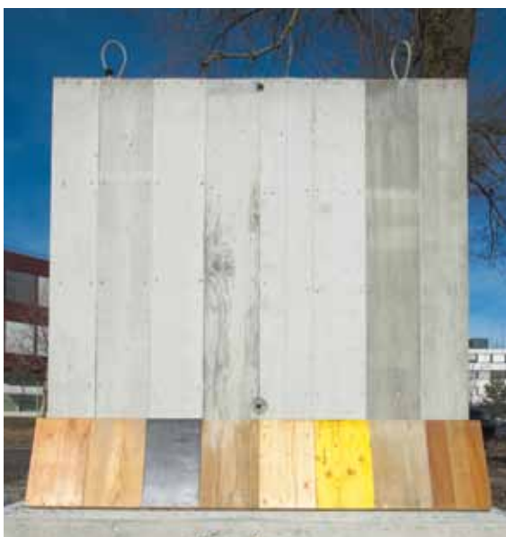
Abb. 14 Zusammenstellung von Sichtbetonoberflächen mit unterschiedlichen Schalungshäuten.
