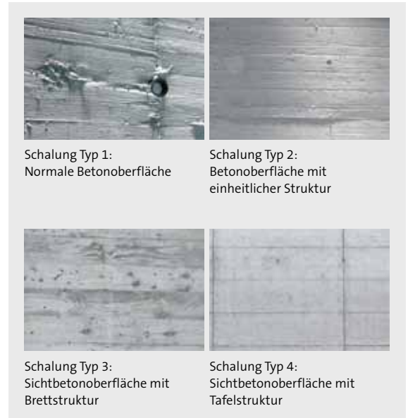
Abb. 17 Schalungstypen 1 bis 4 gemäss Norm SIA 118/262 [1].
